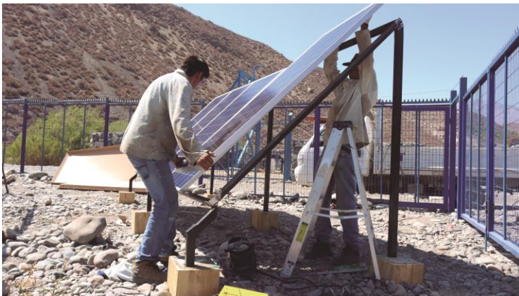
Mejoramiento Sistema Agua Potable Rural
